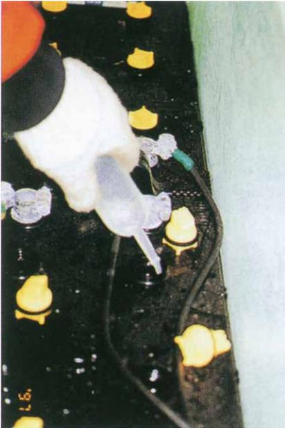
蒸留水補給作業
