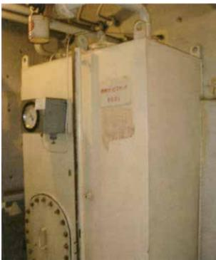
燃料がオーバーフロー→直下の主機関排気管の熱源で引火
