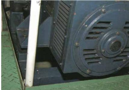
発電機の吸い込み部近辺に油脂類を放置→脂気を吸い込みコイルに付着→発電機焼損
